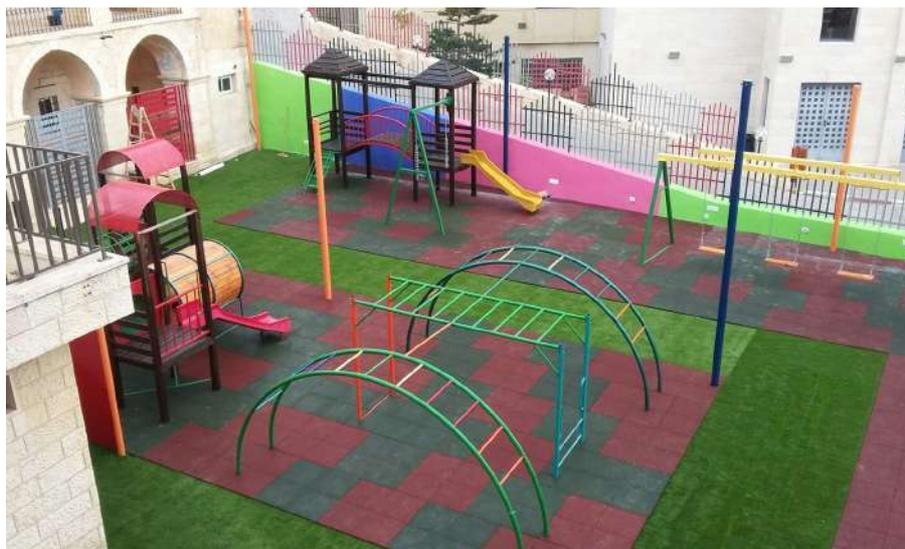
In ultimo, è stata installata la nuova pavimentazione antiurto, in parte di gomma e in parte in erba sintetica.
