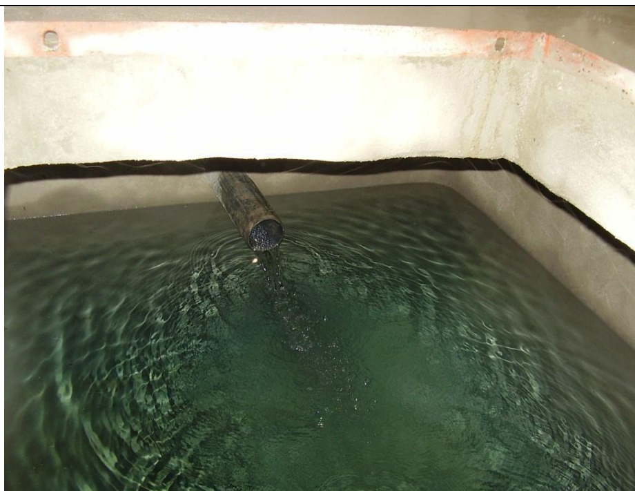
Test impermeabilità delle vasche di trattamento
