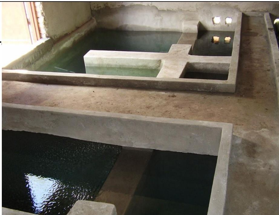
Test impermeabilità delle vasche di trattamento
