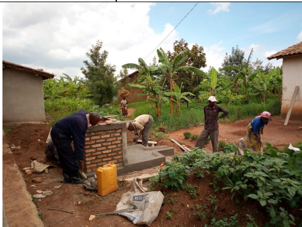
Costruzione di una fontana
