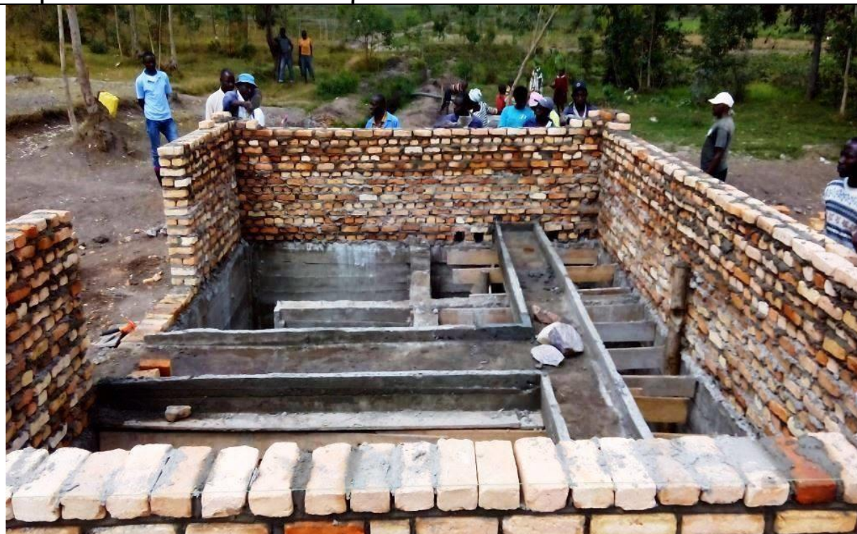
Costruzione di riserva e stazione di trattamento
