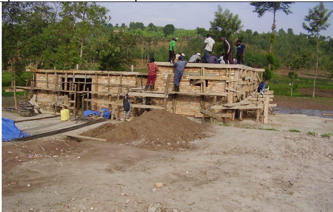
Costruzione di riserva e stazione di trattamento
