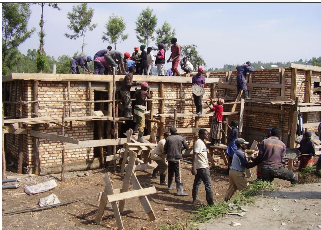
Costruzione di riserva e stazione di trattamento
