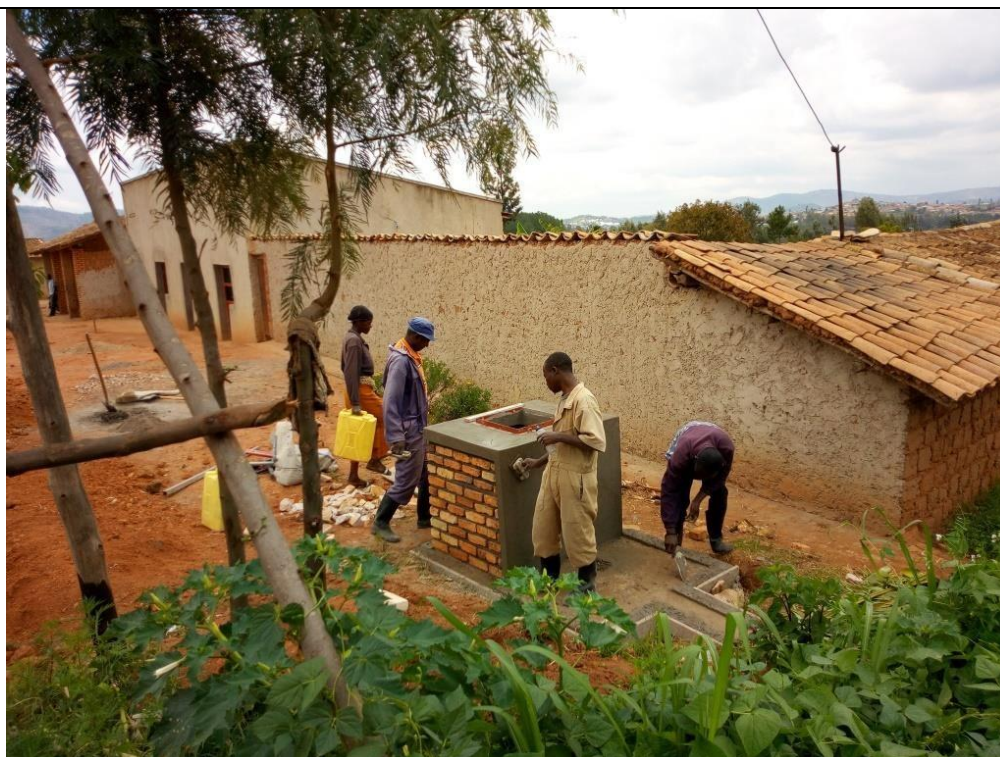
Costruzione di una fontana
