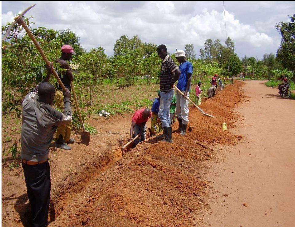
Scavi trincee per distribuzione
