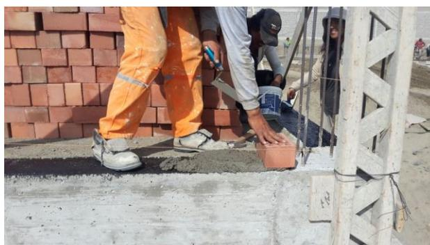
Sono poi state eseguite le colonne e in seguito i muri laterali e interni, realizzati con mattoni portanti a diciotto buchi, per dare più consistenza alle pareti in caso di sisma. La struttura è poi stata fermata fino all'esecuzione del solaio in latero cemento, fatto nel mese di maggio.
