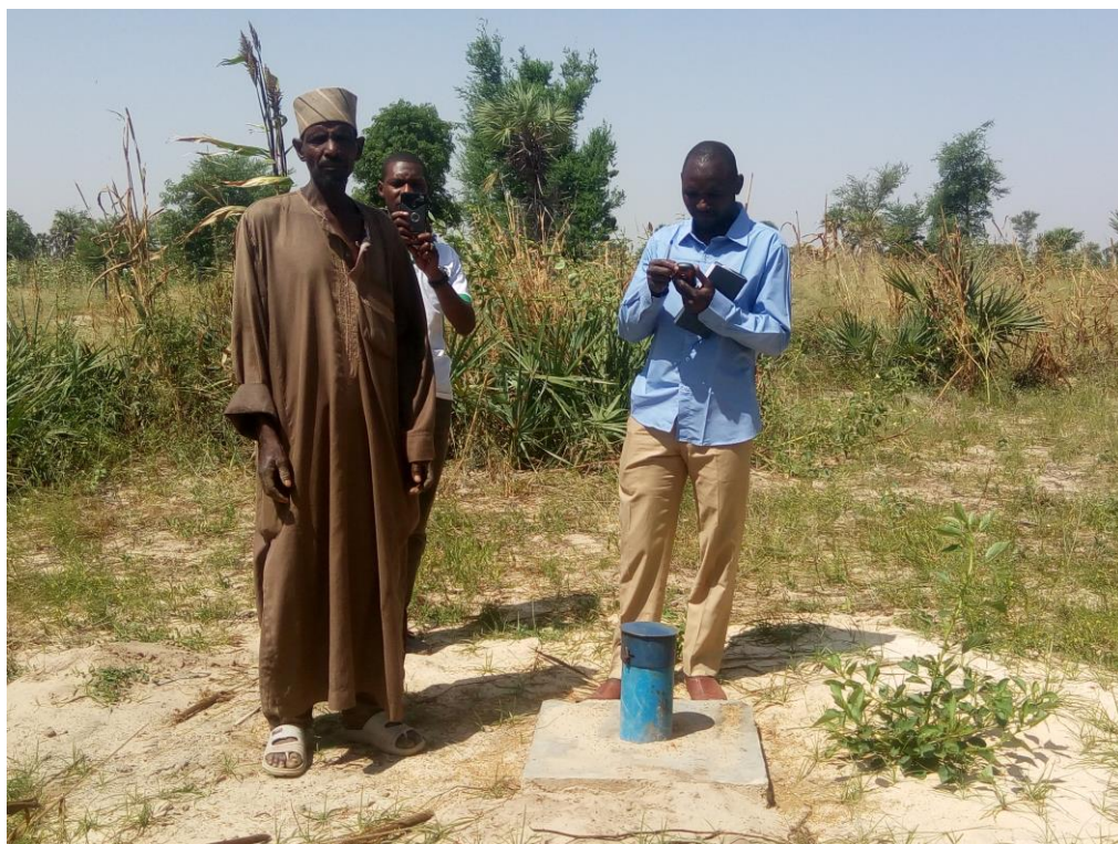
Foto 3. Come si presenta il pozzo realizzato e temporaneamente chiuso con un tappo.
