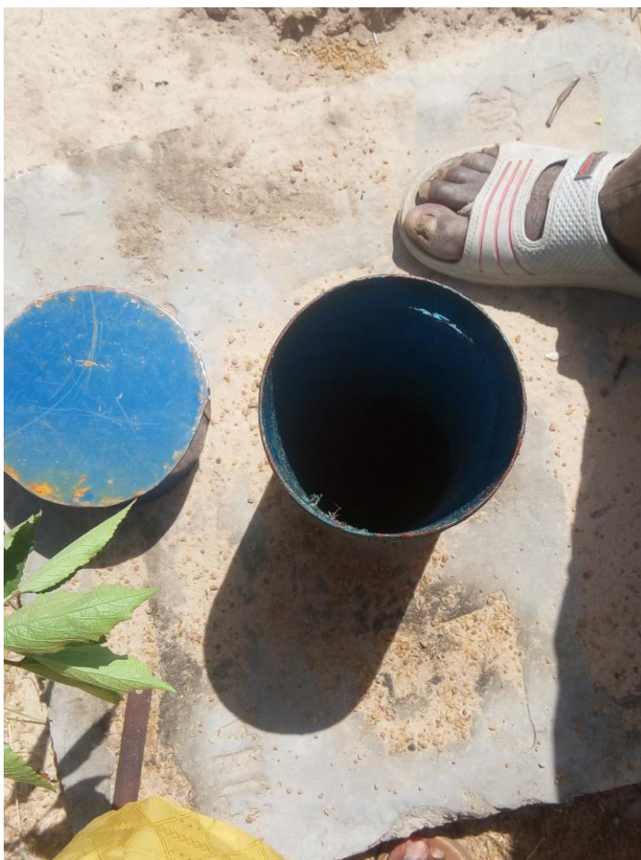
Foto 4. Nel pozzo (forage), viene calato il tubo della motopompa che pesca nella falda acquifera.
